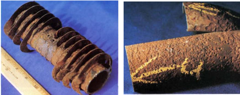
Şekil 14. Sülfürik Asit Korozyonuna Uğrayan Boru Örnekleri [7]
